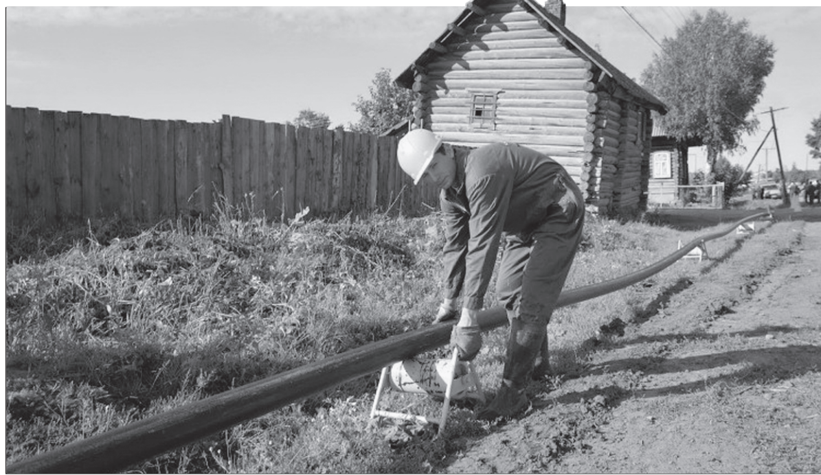
«Тюменьмежрайгаз» завершает прокладку межпоселкового газопровода в Ярковском районе.
